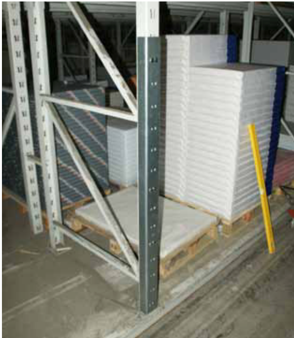
Abb. 18: Repariertes Regal : Nach dem Richten wurde die Stütze mit einer Verstärkung versehen
