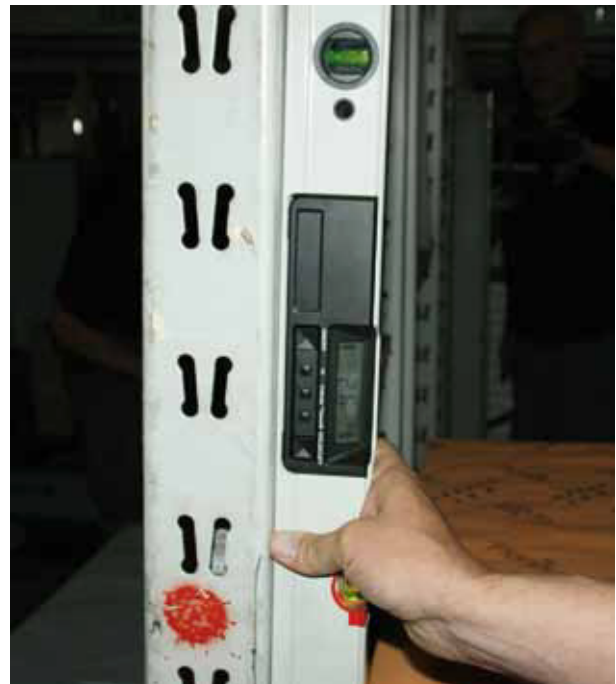
Abb. 10: Messung der Schiefstellung mit digitaler Wasserwaage
