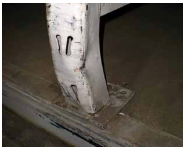
Abb. 12: Gerissene Schweißnaht an der Fußplatte der Stütze
