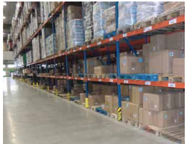
Abb. 19: Stützenschutz an allen Stützen
