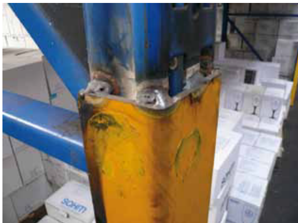
Abb. 11: Unfachmännisch geschweißte Stütze
