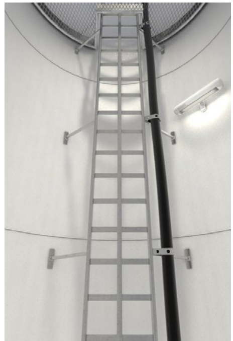
Abb. 20 Steigleiter in einer Windenergieanlage
