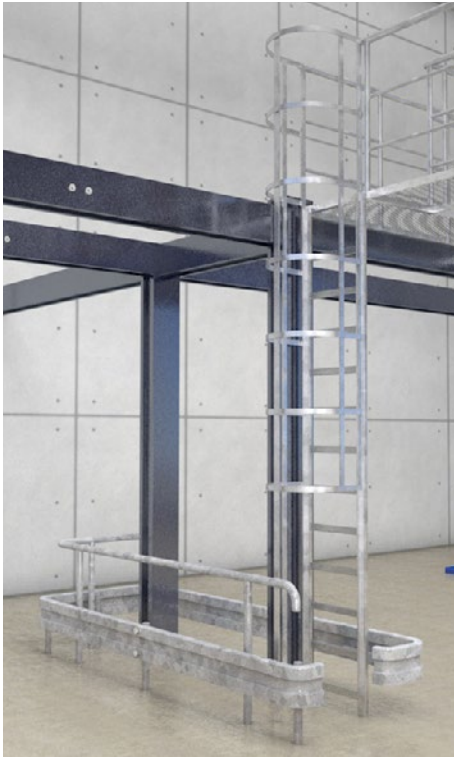
Abb. 9 Vermeidung von Gefährdungen durch konstruktive Maßnahmen
