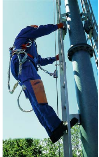
Bild 20: Beispiel einer Steigschutzeinrichtung mit Führung aus Stahldrahtseil
