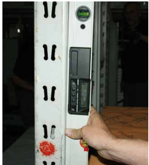
Abb. 10: Messung der Schiefstellung mit digitaler Wasserwaage
