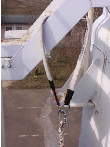
Abb. 14 Beispiele für Anschlageneinrichtungen der Klasse B – Bandschlinge, Trägerklemme
